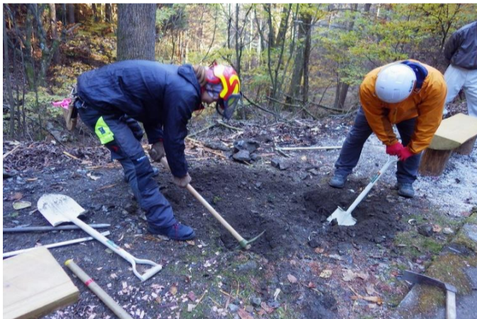
総出で穴掘り作業をしました
