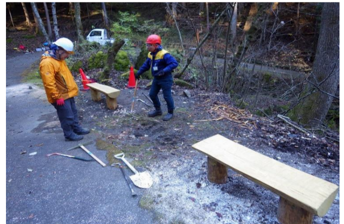
一番大変な設置場所の穴掘り作業
