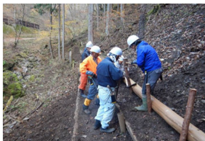
崩壊地沿いの登山道に土留めの施工
