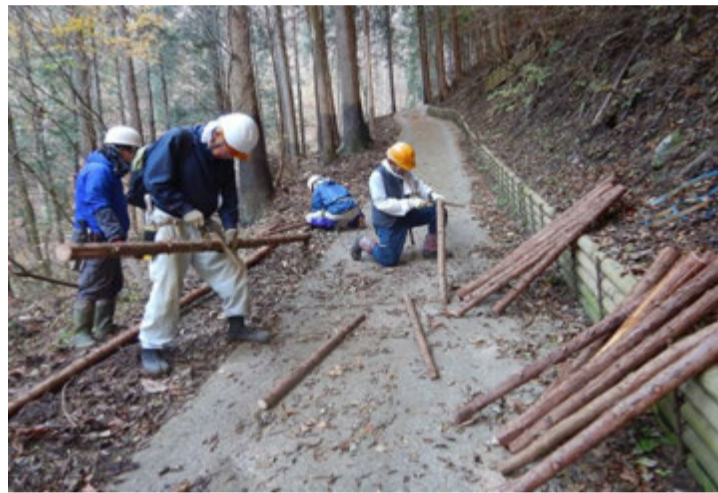
崩壊地沿いの登山道に土留めの施工
