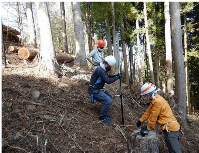
支柱の打ち込み
